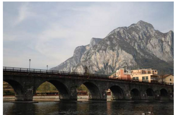
Il ponte di Azzone Visconti, costruito per collegare la Valsassina con il Ducato di Milano
