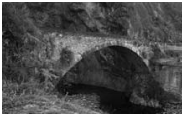
Fig. 2 (in alto): Sulla Lesgiüna venne costruito il primo ponte cantonale. Il manufatto, progettato dall'ingegner Meschini nel 1807, seppur non utilizzato da lungo tempo si conserva ancora in ottimo stato (foto Massimo Colombo).
