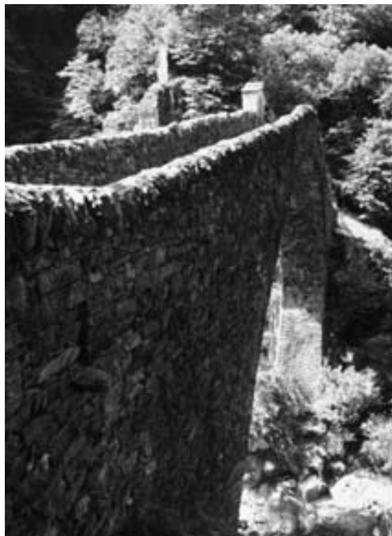
Fig. 4: Il notevole arco del Ponte Nuovo di Intragna sul fiume Melezza, all'imbocco delle Centovalli (foto Massimo Colombo).
